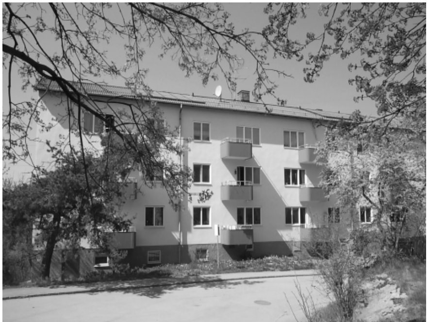
Från gatan finns inte mycket som visar att här hos Brf Kärnvirket i Stureby i Stockholm finns en unik trekombination för värme- och energibesparing bestående av såväl bergvärme, solfångare - som syns svagt på taket - och pelletspanna för spetsvärme vintertid. Anläggningen kostade en miljon, men med en årlig besparing på 200.000 kronor jämfört med tidigare oljeeldning ligger man snart på plus!
