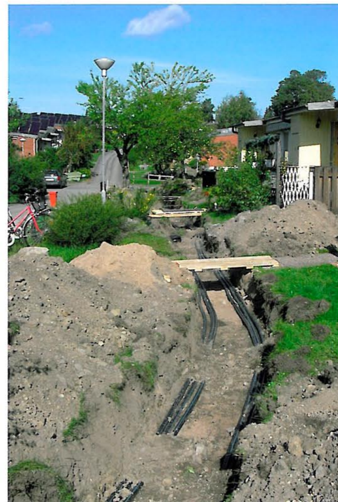
Slangförläggning från borrhålen.
